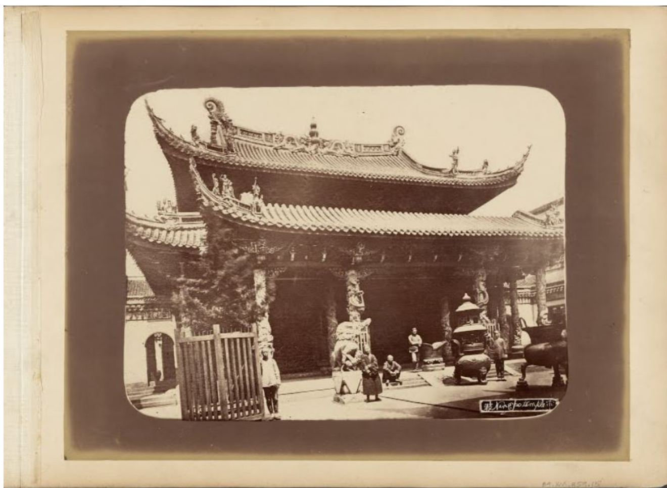
Un tempio tradizionale a Ningbo
